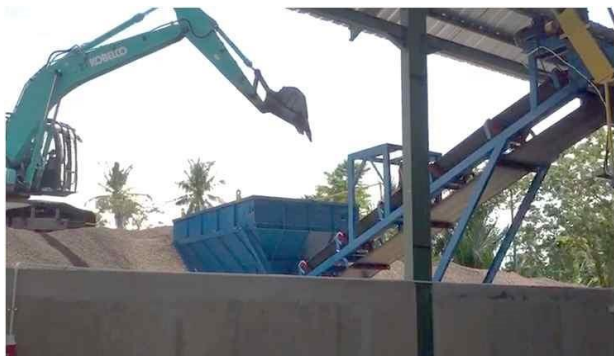
① 精錬工場ヤードから、大きな不純物除去ホッパーへ投入
